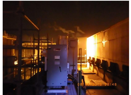
更換高頻變壓器
