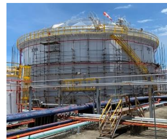
苯外浮頂槽加蓋(改善中)
