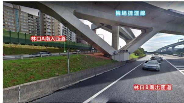
匝道設計標準採設計速率  $V_d=50$  公里/小時，林口 B 南出匝道於國 1 里程 40+900 岔出主線，主線平行段及漸變段布設於里程 40+700~40+900 間，出口匝道布設主線路面局部加寬改善，文化一路跨越橋橋台邊坡須拆除改善並增設擋土牆構造物。
