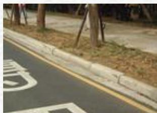
圖4.13-1 L型導水溝實例
