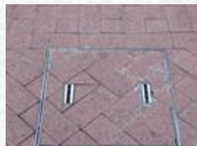
圖4.6-2 孔蓋邊緣收邊材質與鋪面材質諧調實例
