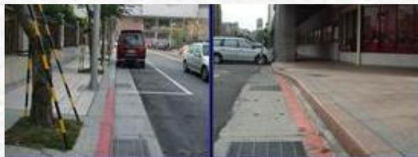
圖4.13-3 平面格柵進水口實例
