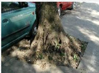
圖4.7-6 隆起的根易破壞鋪面實例
