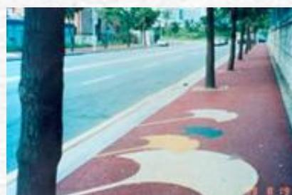
圖4.6-8 現場整體澆置透水鋪面實例
