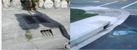
圖4.13-2 側面緣石進水口實例
