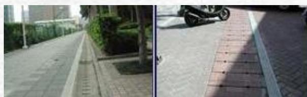
圖4.13-5 平面溝蓋實例
