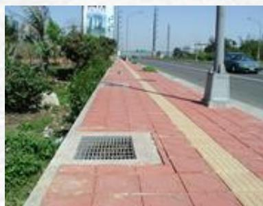
圖4.13-6 排水溝格柵蓋板影響行走空間實例
